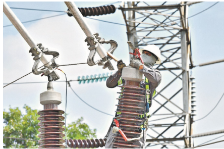
Lluvias provocan salida de varios circuitos eléctricos.
