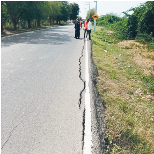
Defensa Civil dice esas grietas llevan varios meses.
