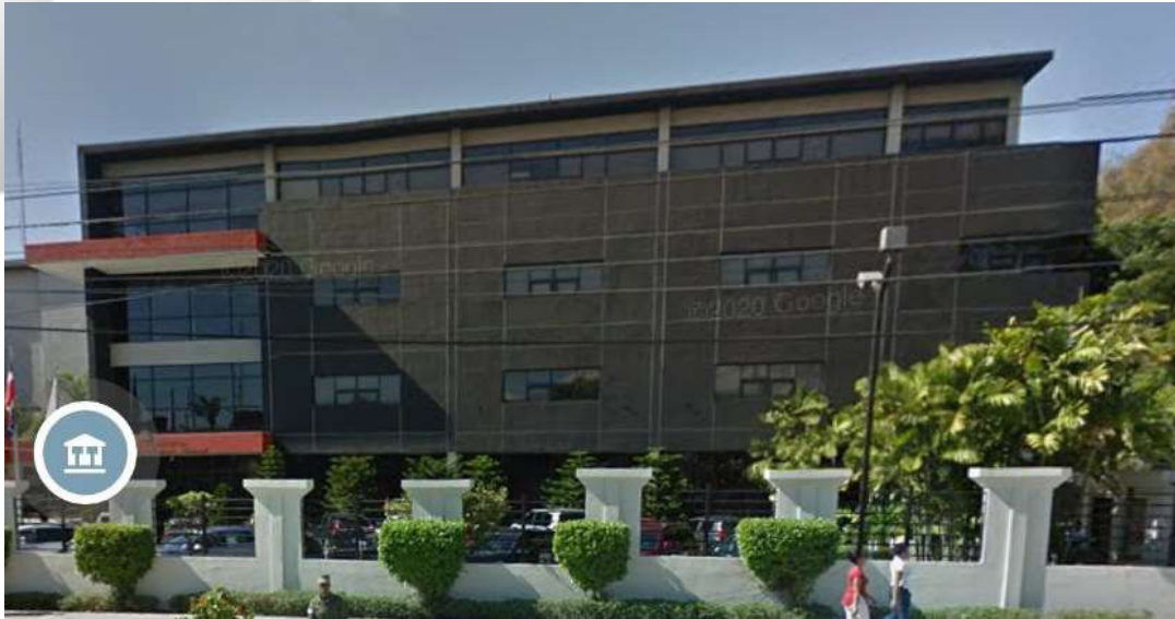
VISTA DEL EXTERIOR DE LA ZONA DEL EDIFICIO A LAMINAR (NIVEL 3 Y 4)
