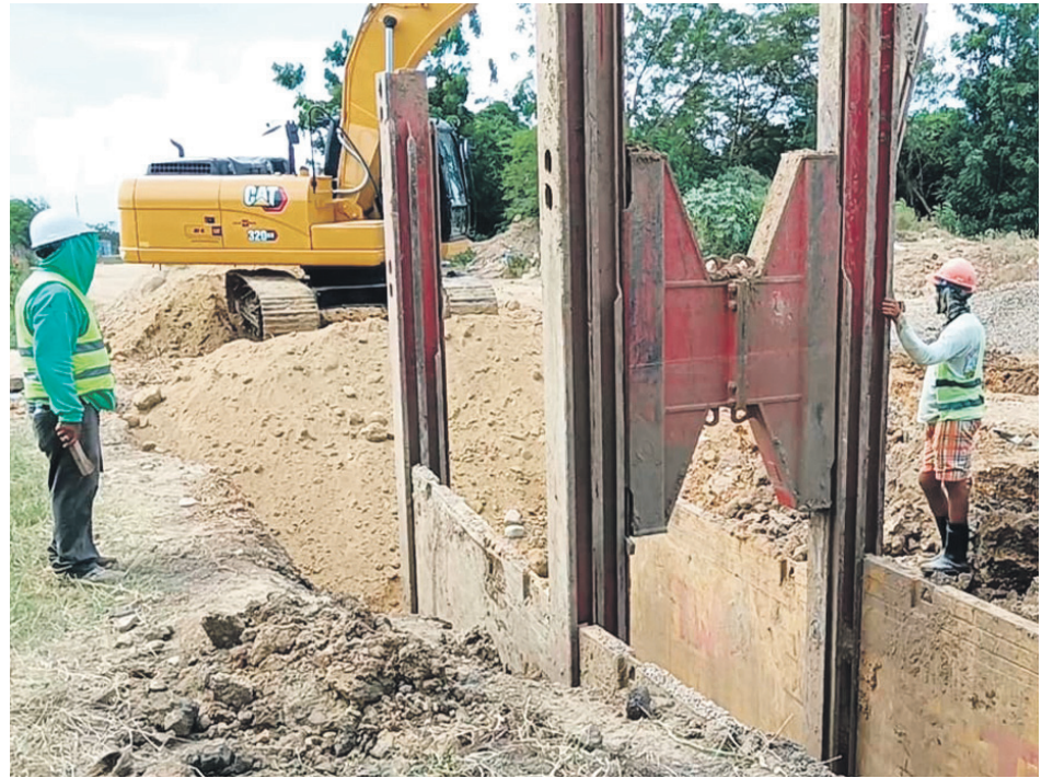
Trabajadores avanzan en la obra para cumplir la promesa del director de INAPA, Wellington Arnauld, de completarla en 10 meses.
